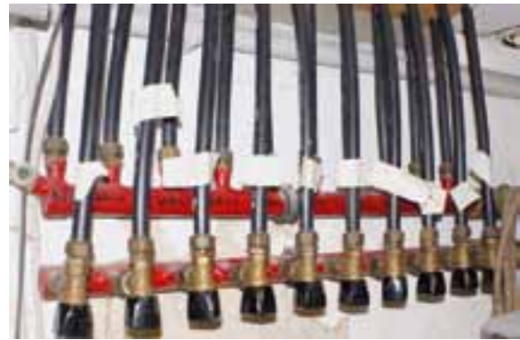
Verteiler mit Hand-Beschriftung
