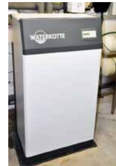
Der Nachfolger, die Waterkotte DS 5027 (Grundwasser) mit 22 kW Heizleistung
