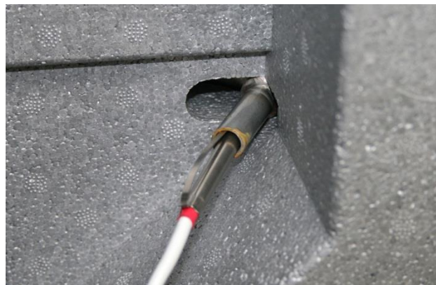
Abbildung 14: Tauchhülse mit Temperaturfühler am Edelstahlspeicher
