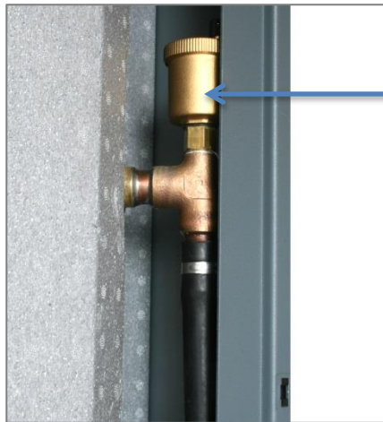
Abbildung 8: Speicheranschluss oben mit Entlüftungsventil
