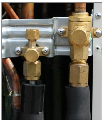
A Absperrventil, Flüssigkeitsseite B Absperrventil Gasseite C Ausgang der Wartungseinheit D Abschnitt öffnen/schließen
