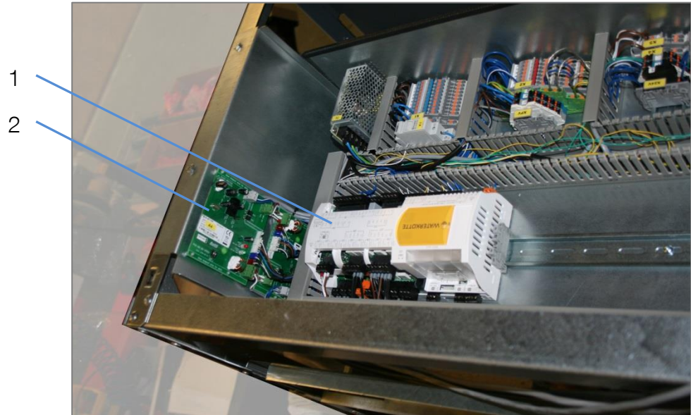
Abbildung 14: Wärmepumpenregler (1) und Schnittstellenkarte (2)
